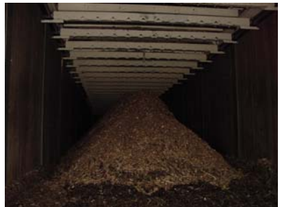
-Silos de carga y descarga
